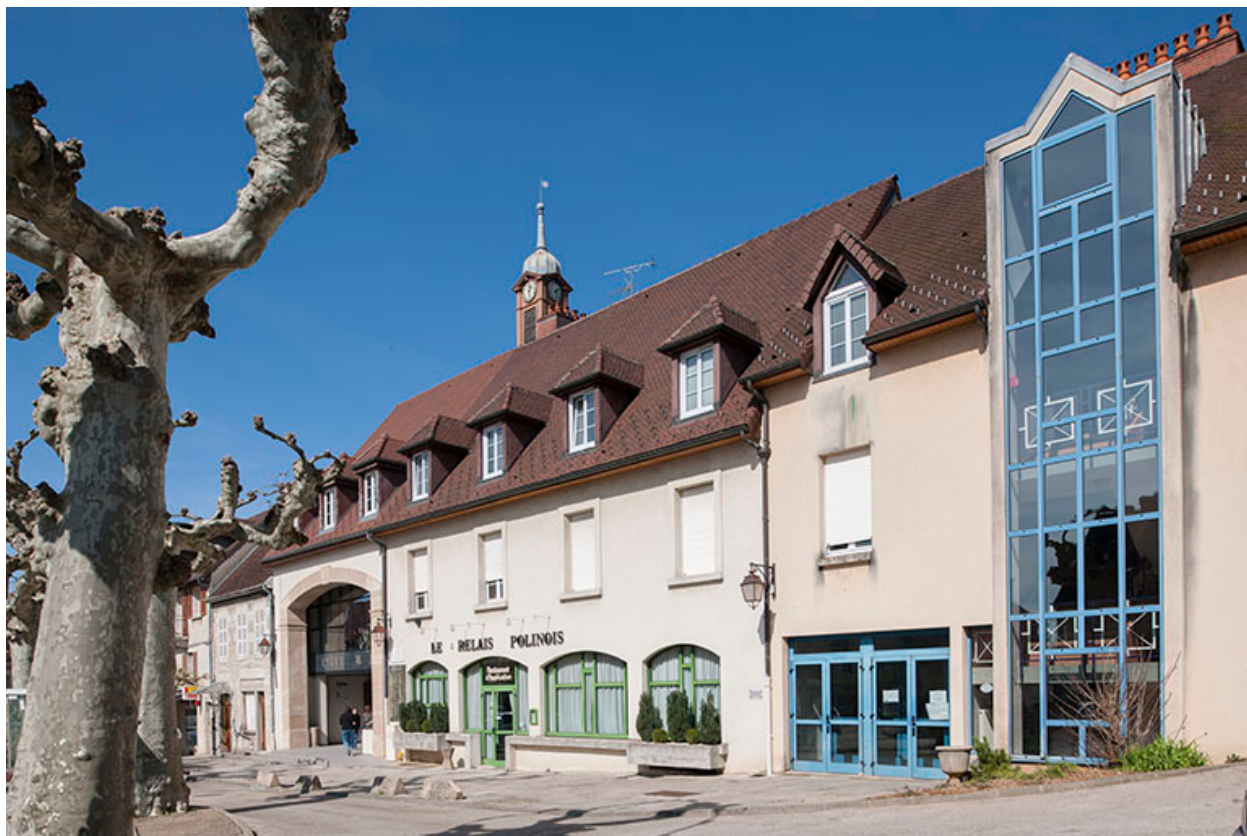
Restaurant d'application: façade antérieure, place des déportés.
