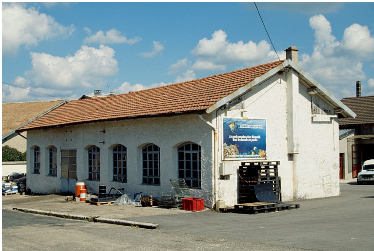
Premier bâtiment, vu de trois quarts droit.
