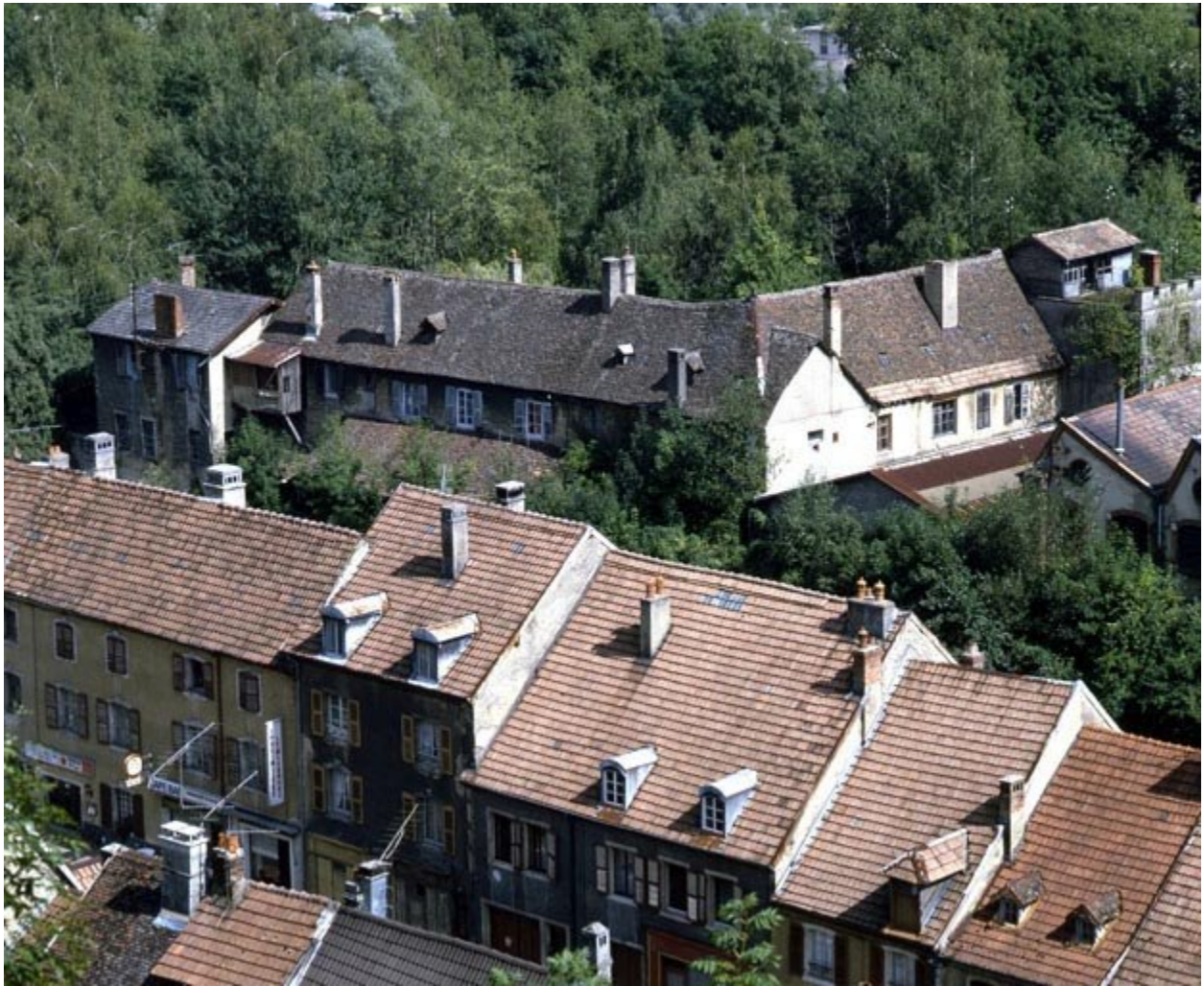
Logement patronal vu depuis l'ouest en 1986.
