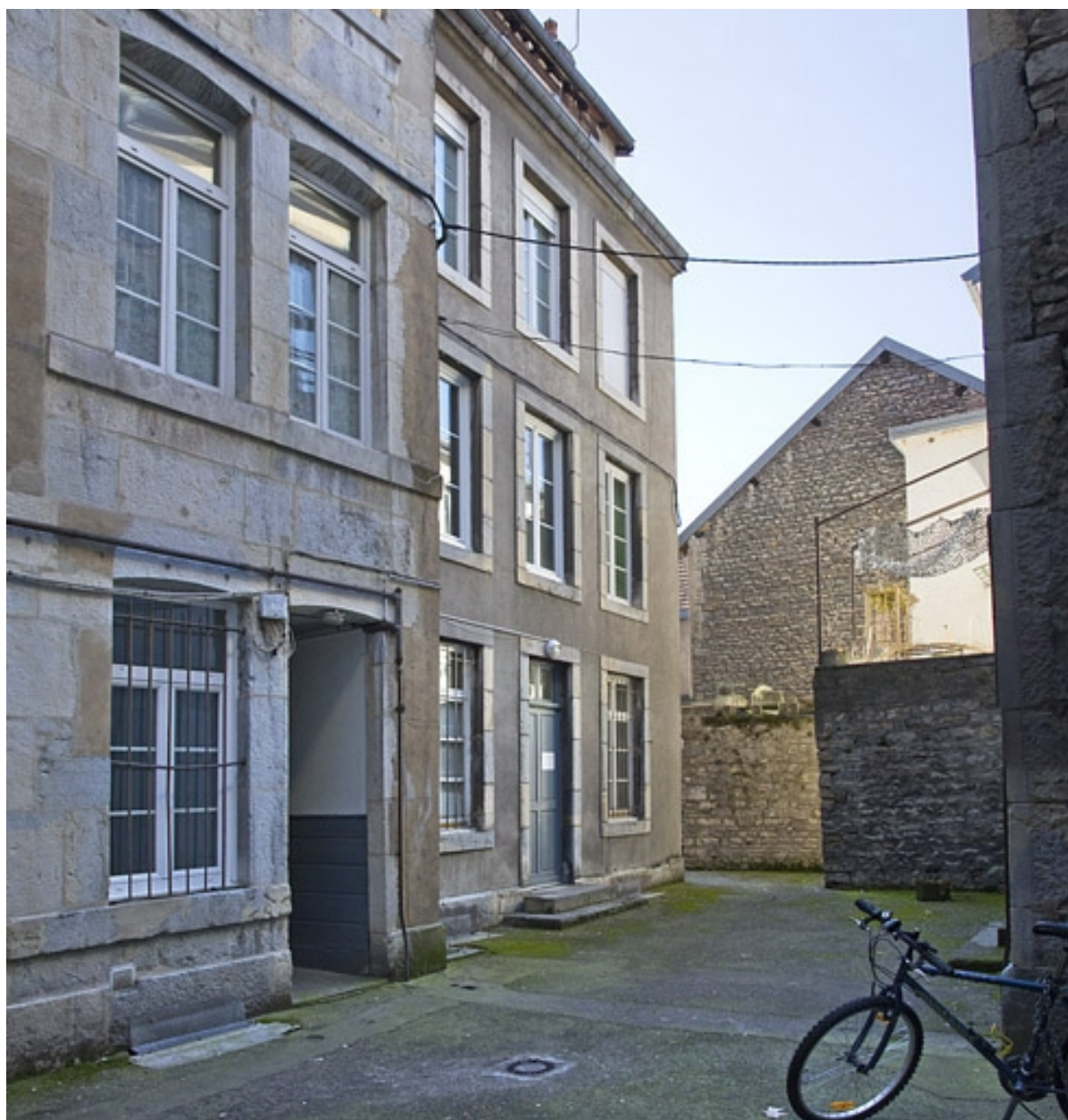
Vue de la troisième cour.
