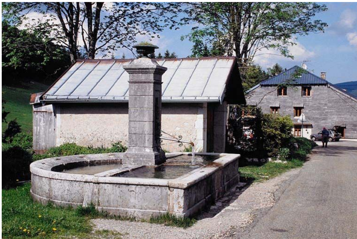
Vue générale de la fontaine.
