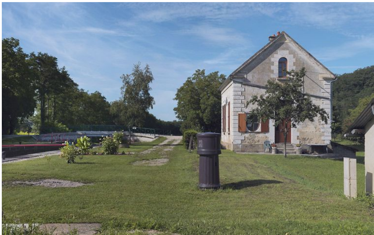
Maison éclusière : pignon regardant vers l'amont.
