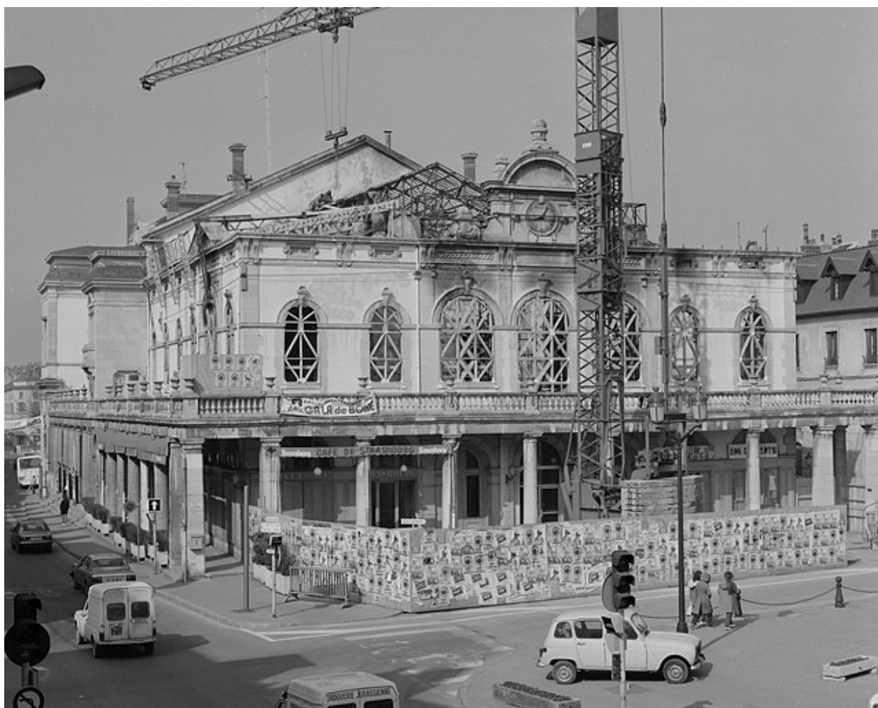
Façade postérieure (après l'incendie de 1983).
