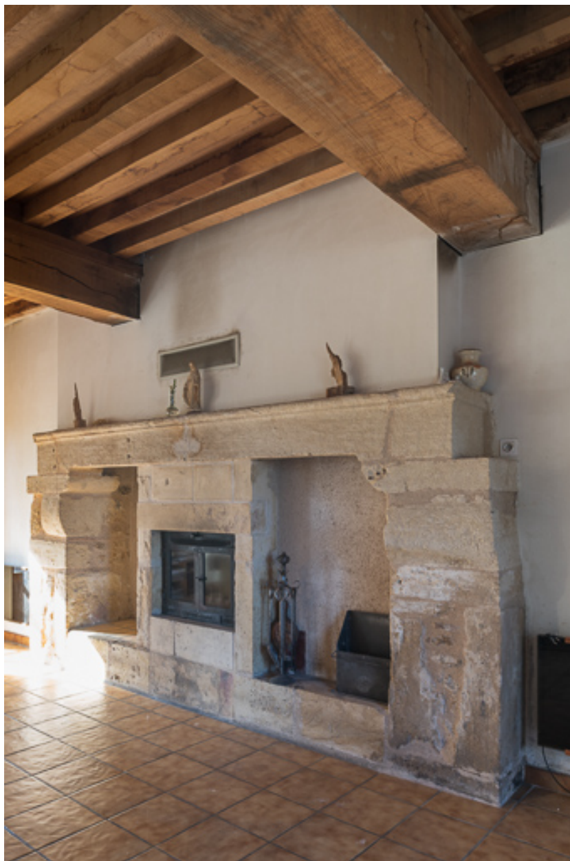
Cheminée de l'ancienne cuisine de la demeure
