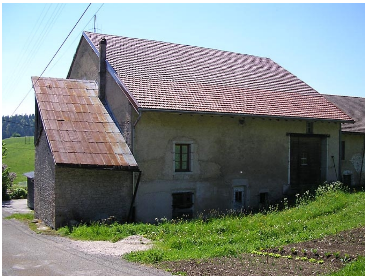
Façade postérieure et remise.
