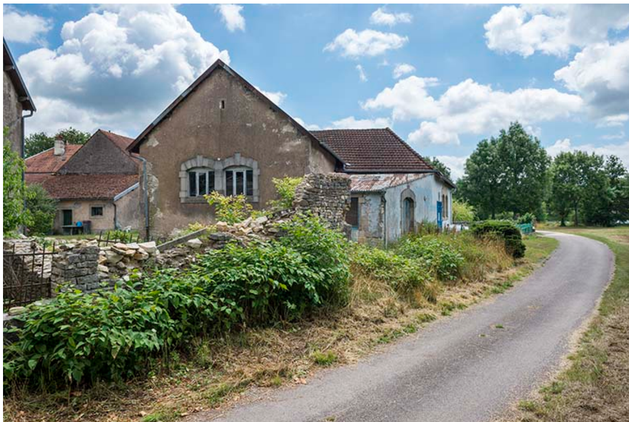
Mur pignon ouest.
