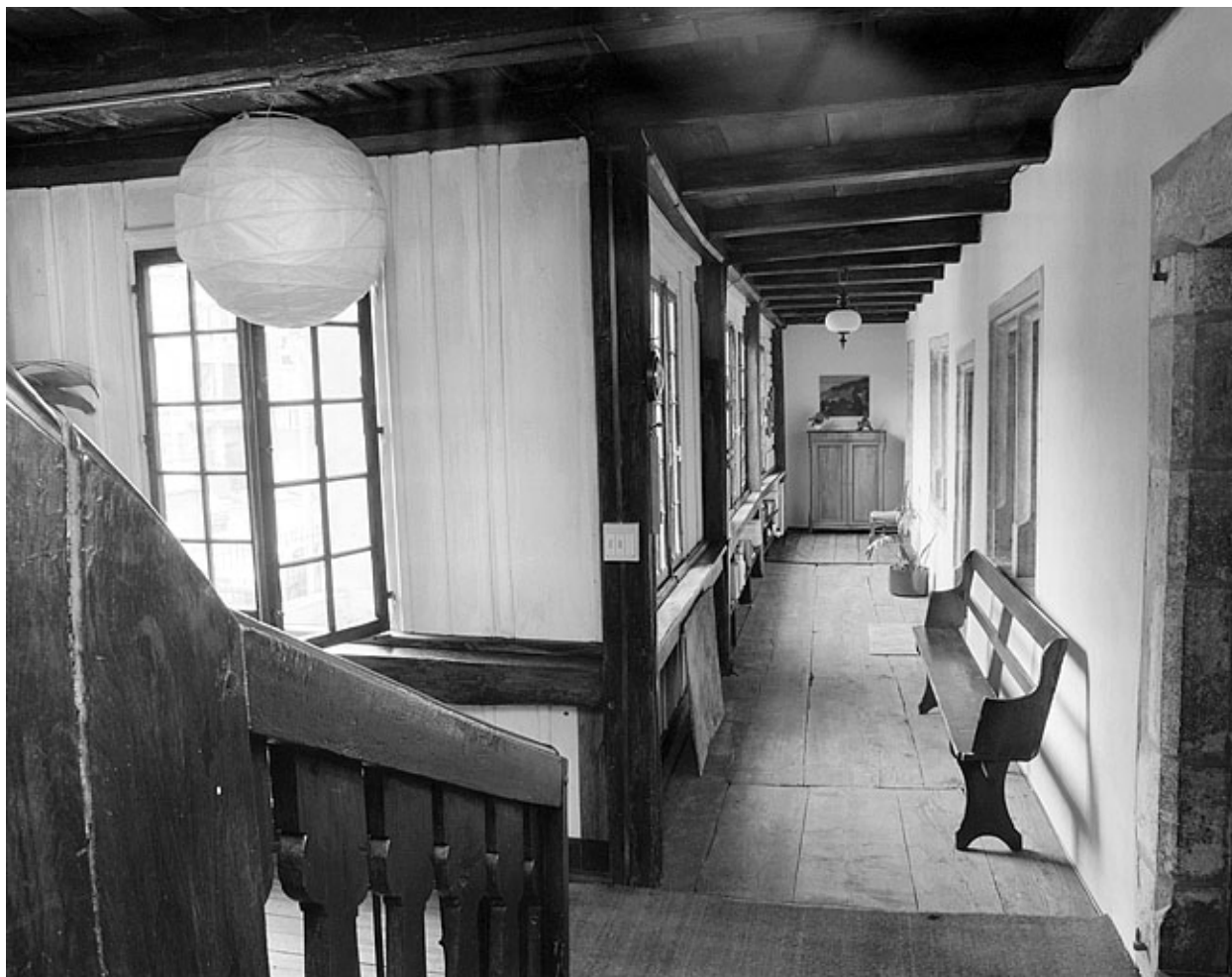
Galerie de distribution du premier étage.
