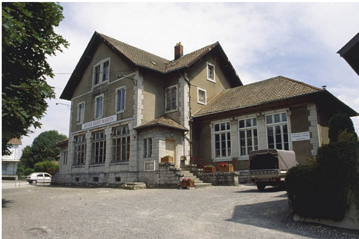
Façade antérieure depuis l'ouest.
