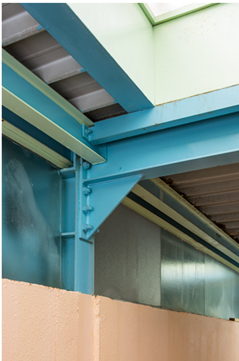
Détail du système poteau-poutre du vestiaire.
