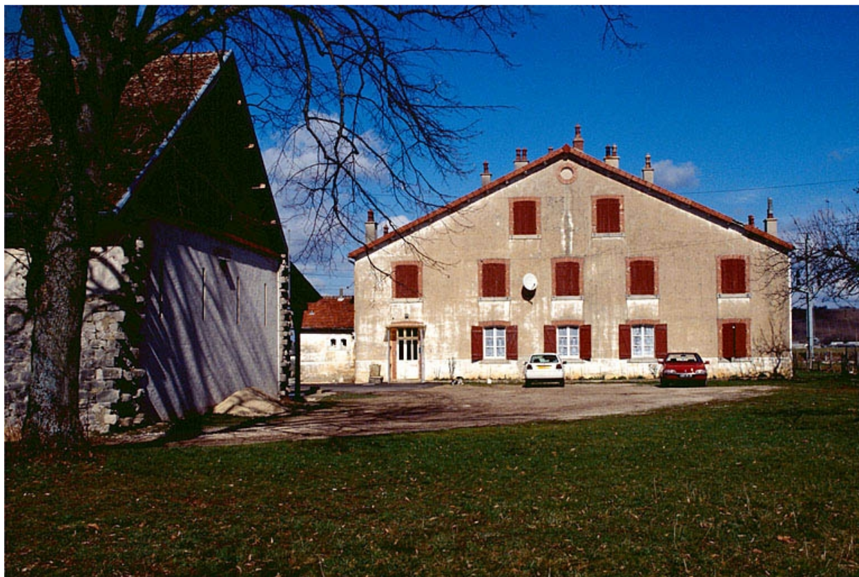
Bâtiment abritant les bureaux et le logement.
