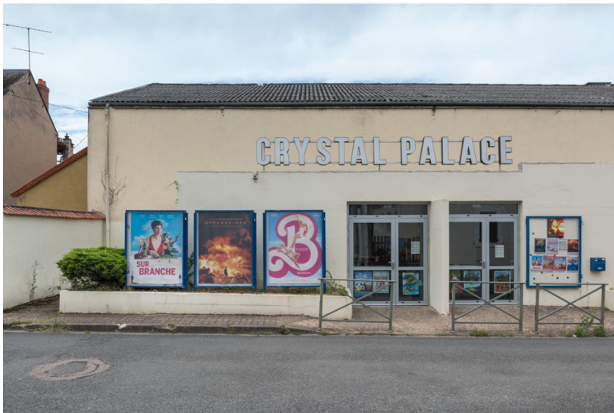
Façade antérieure : entrée.
