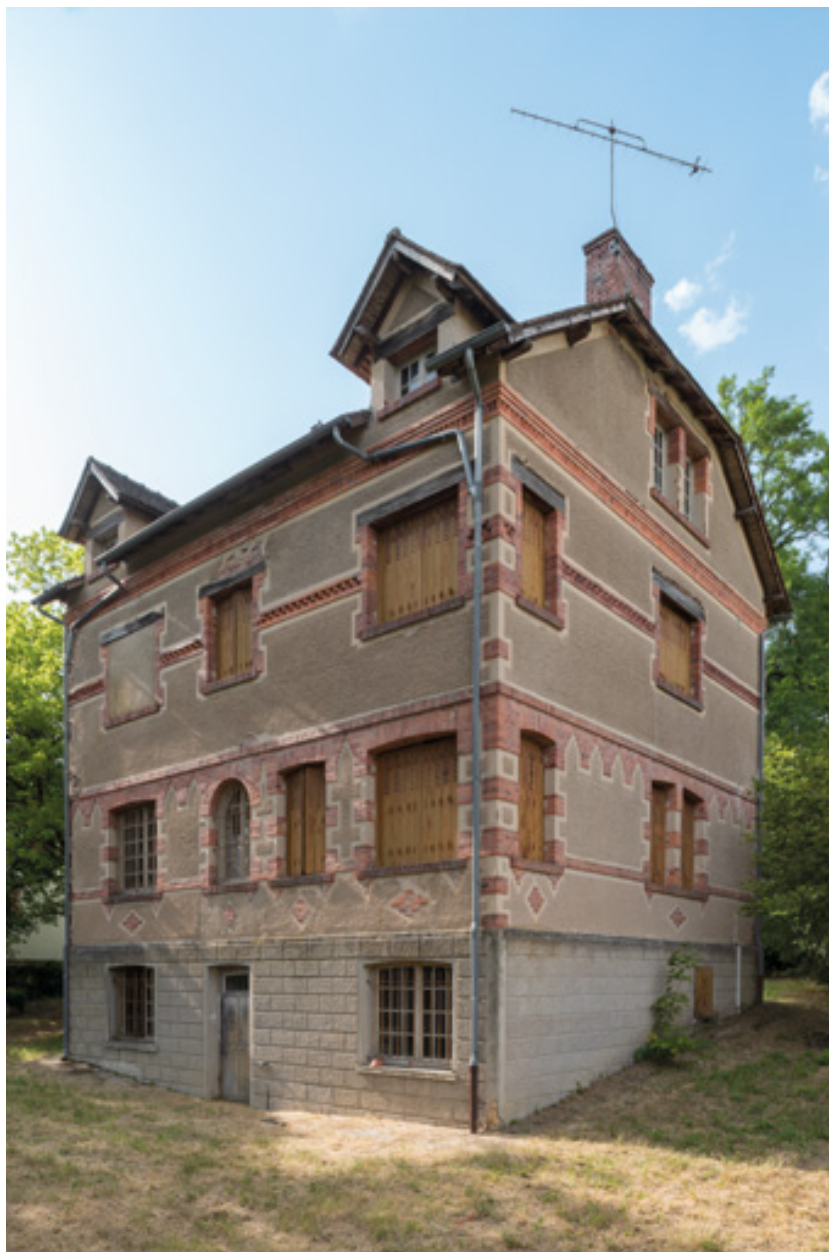
Façade postérieure, vue depuis le sud-est.
