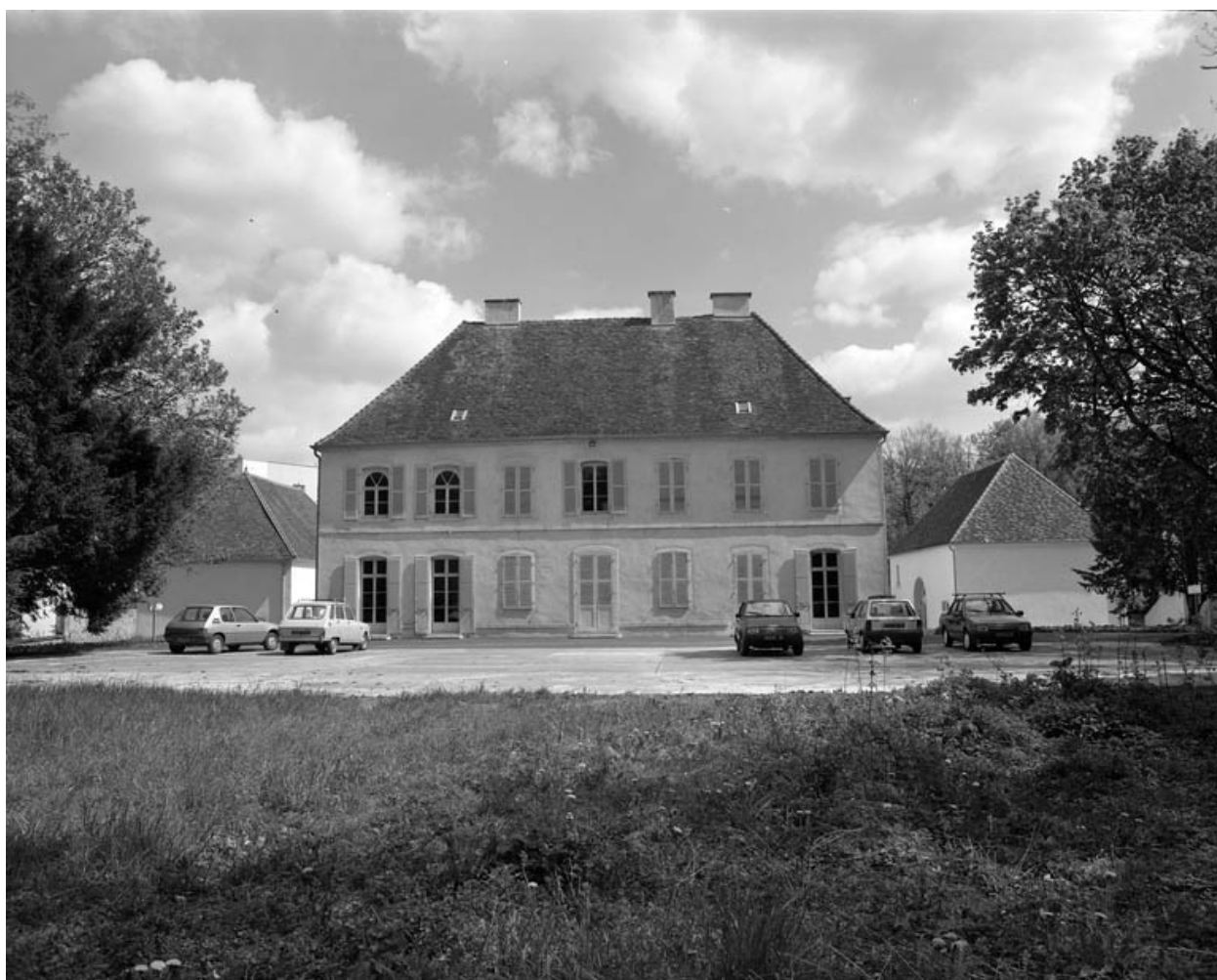
Façade postérieure depuis le parc.
