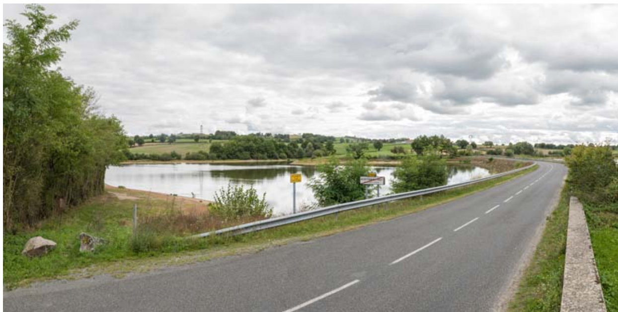
Vue générale du site et de la route-digue.
