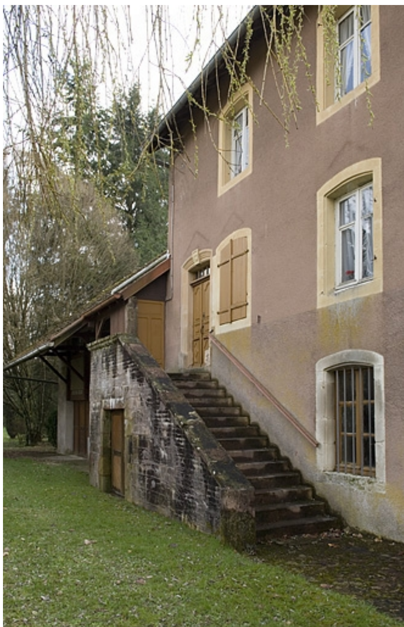
Façade antérieure. Escalier d'accès au logement.
