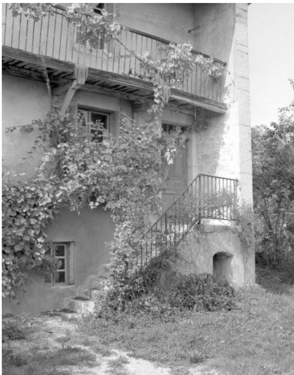
Façade antérieure, accès au logis de droite.
