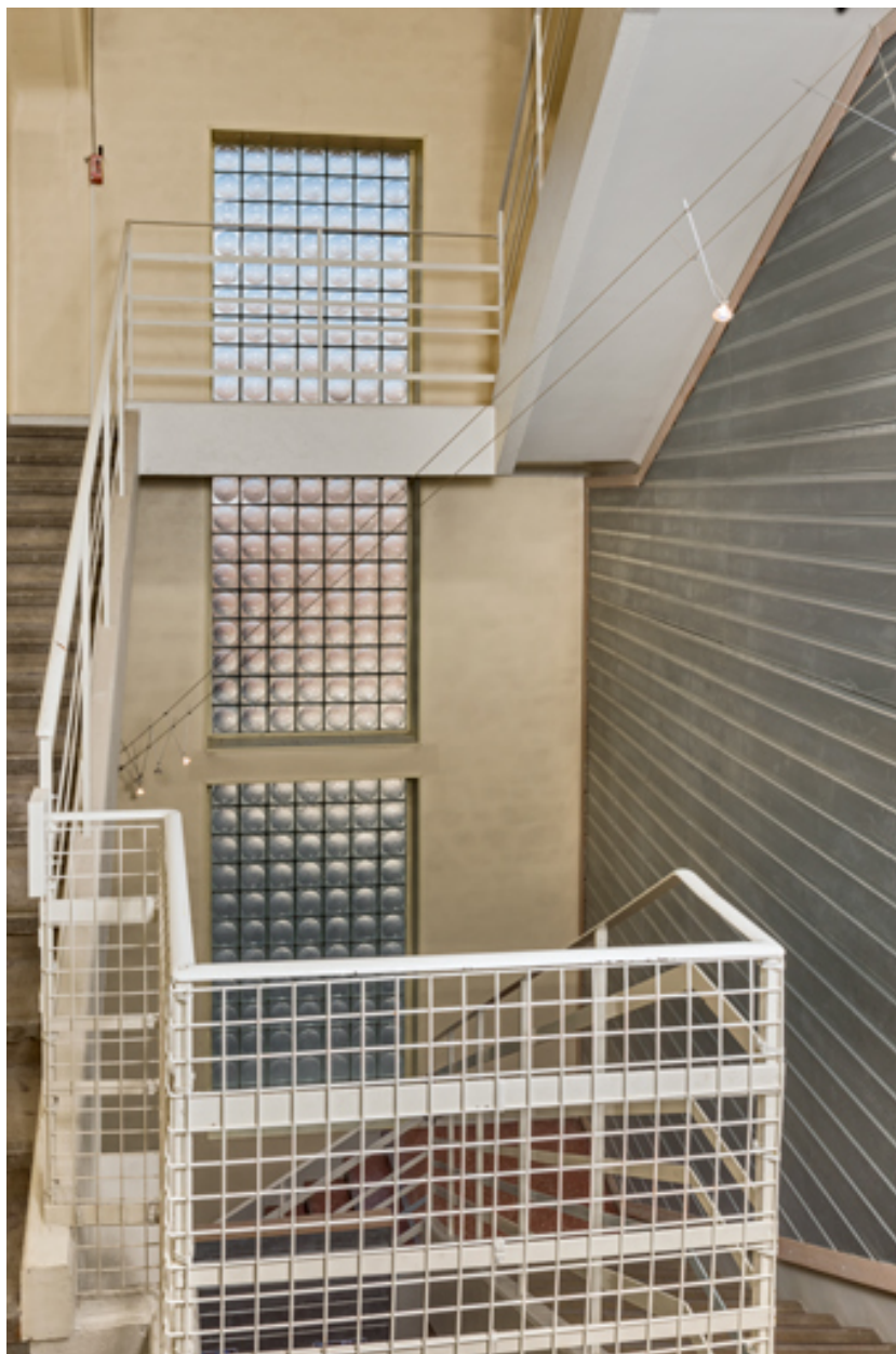
Cage d'escalier, depuis le 1er étage.
