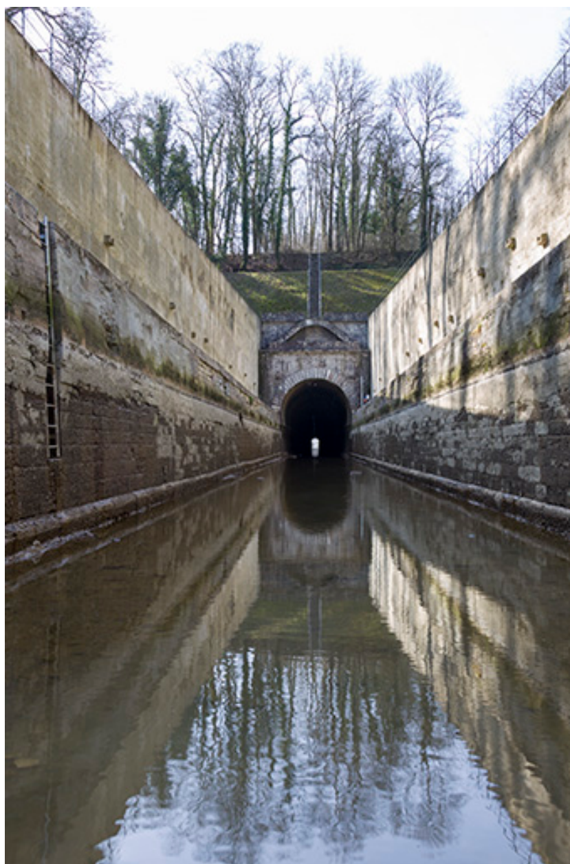
Le souterrain depuis la cuvette du canal.
