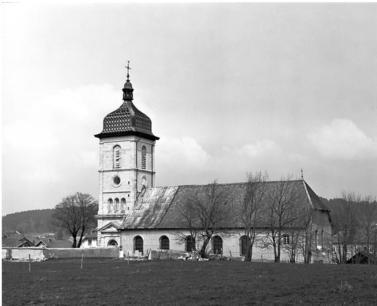
Vue de la façade sud.
