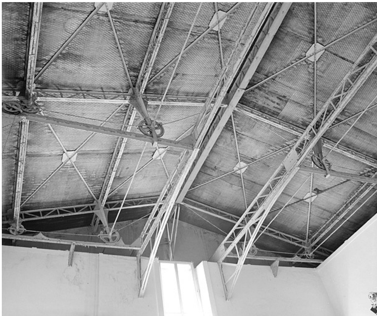
Charpente métallique de la toiture.
