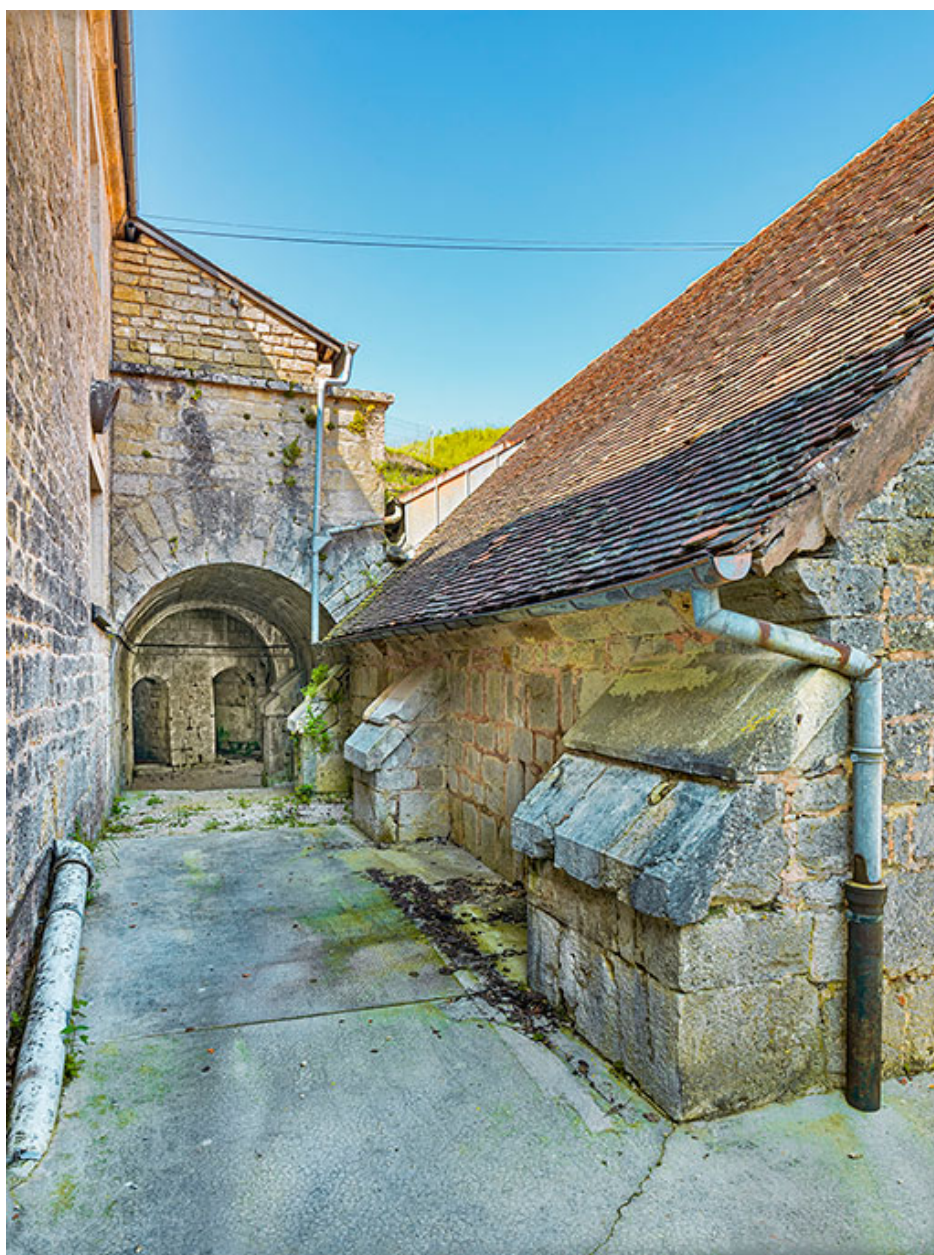
Les contreforts épaulant la poudrière.
