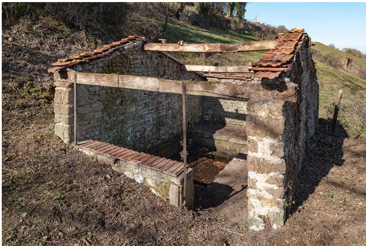
Lavoir du hameau (en cours de restauration)
