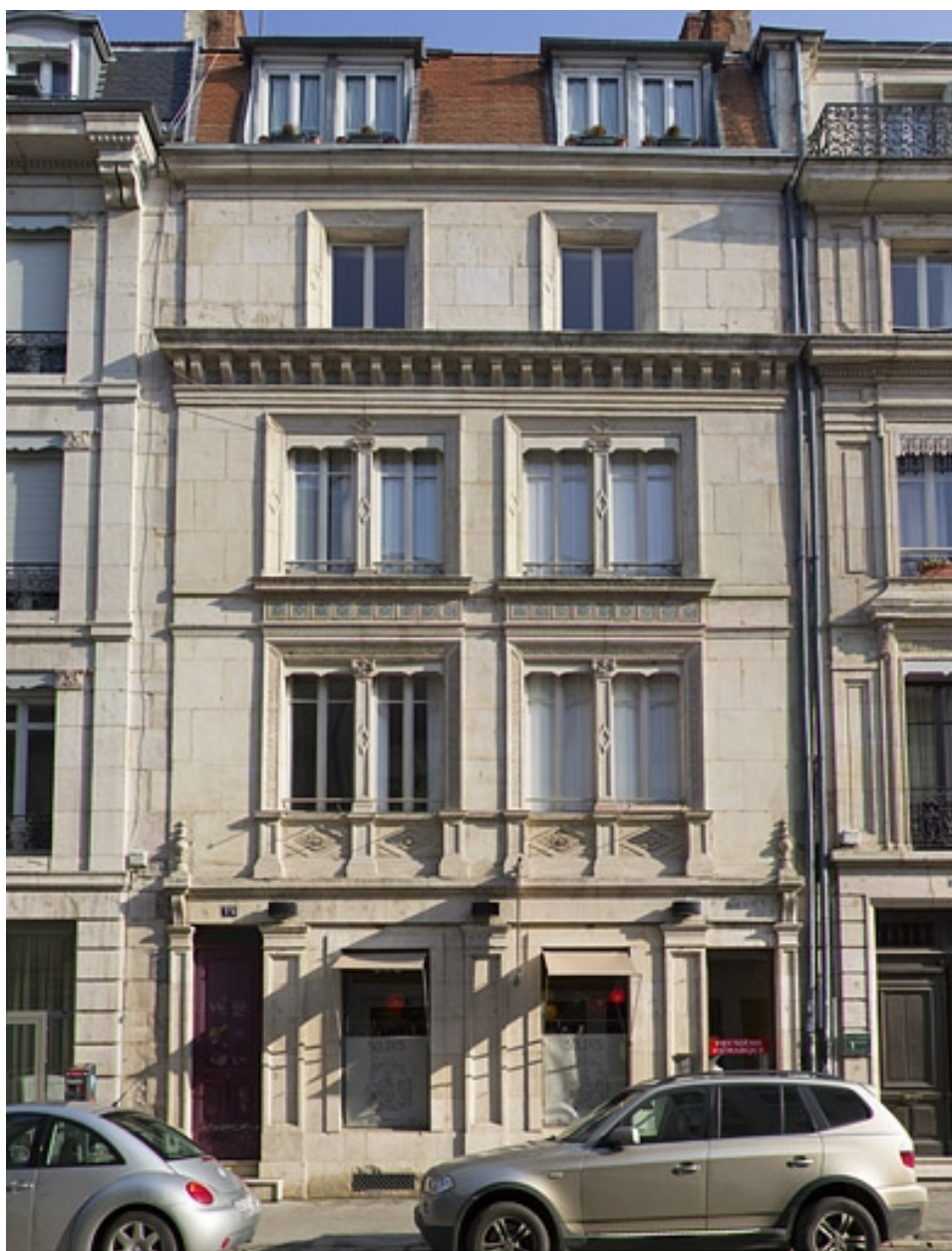
Façade antérieure, de face.
