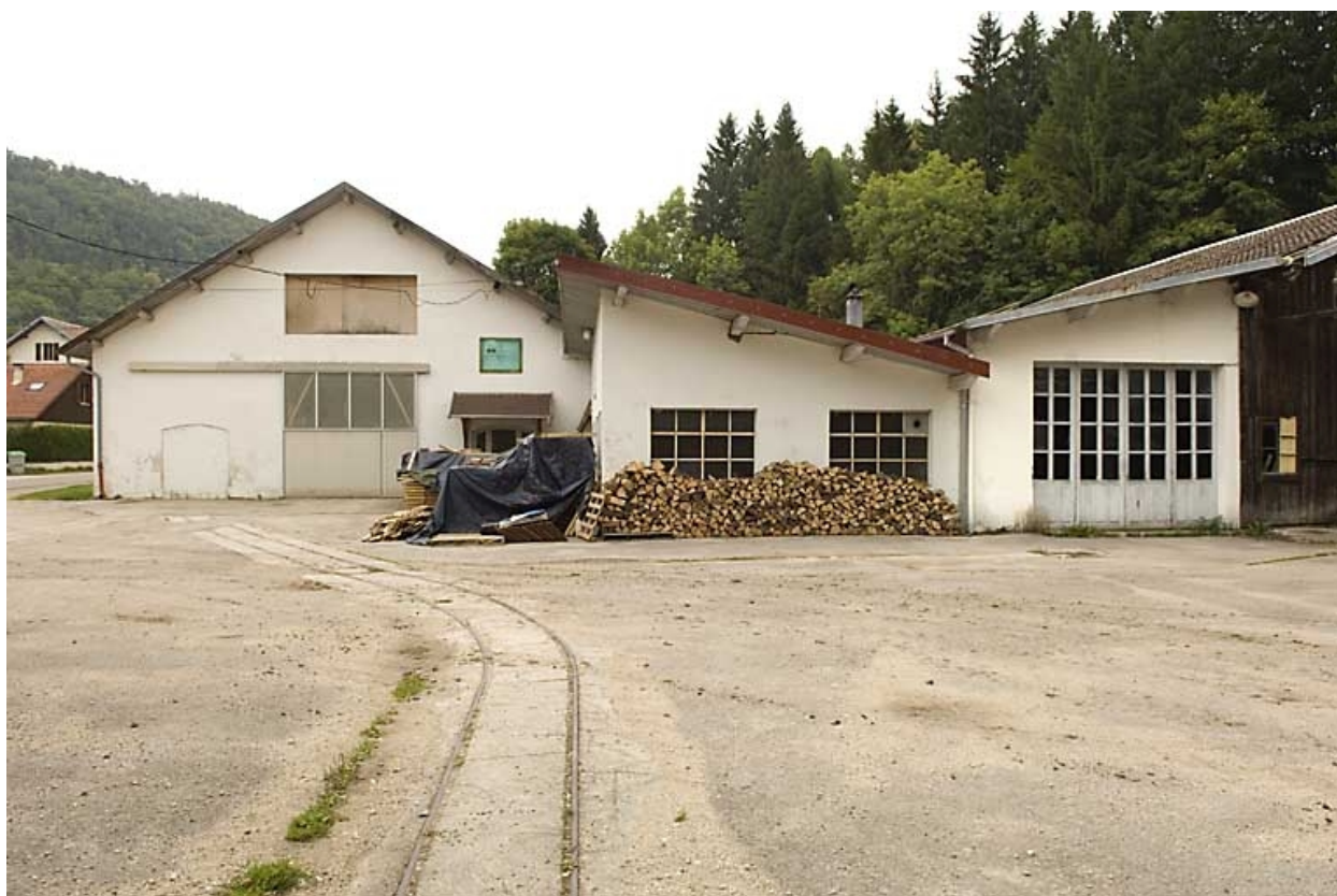
Partie nord : bâtiments vus de face.
