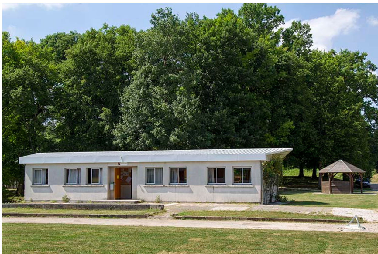
Façade sud des salles des classes préparatoires.
