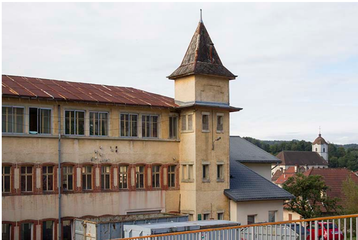
Usine, façade postérieure : tour occidentale.
