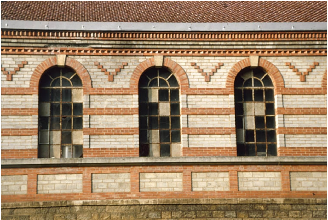
Détail de la façade est de l'orangerie.
