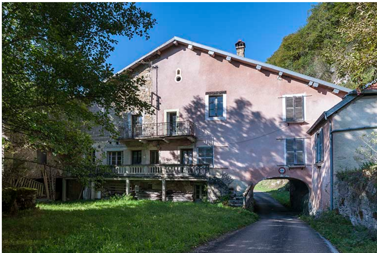
Façade est du moulin.
