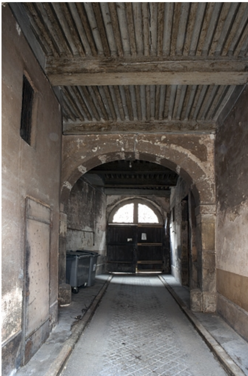
Vue d'ensemble du passage cocher, de face.
