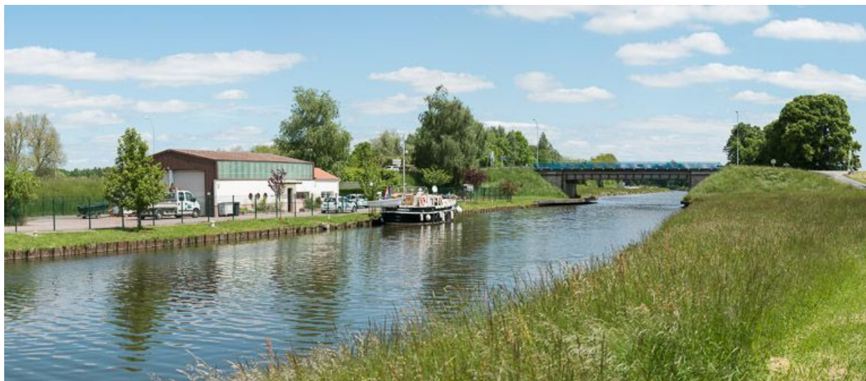
Vue d'ensemble du pont.
