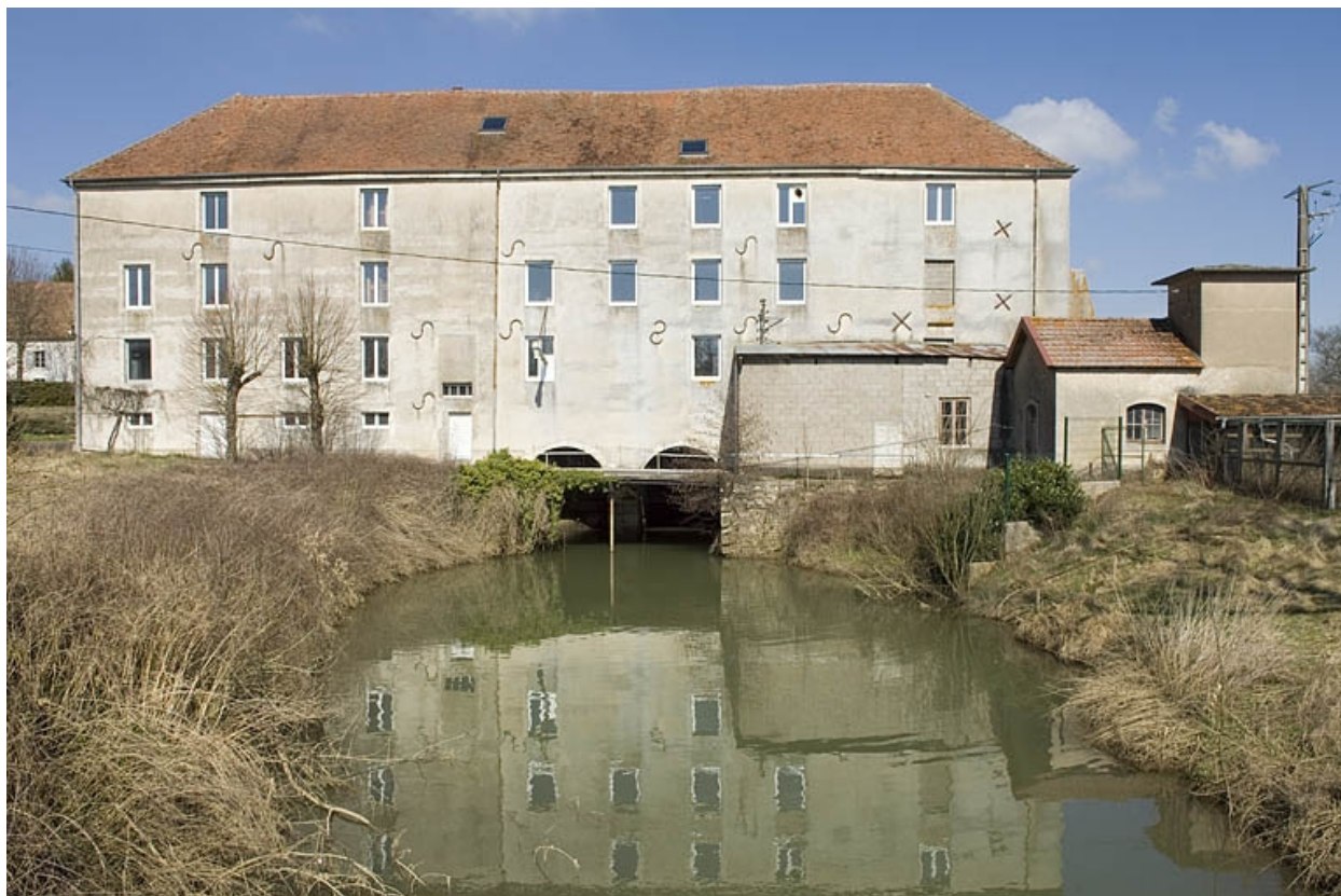
La minoterie et le canal de fuite.
