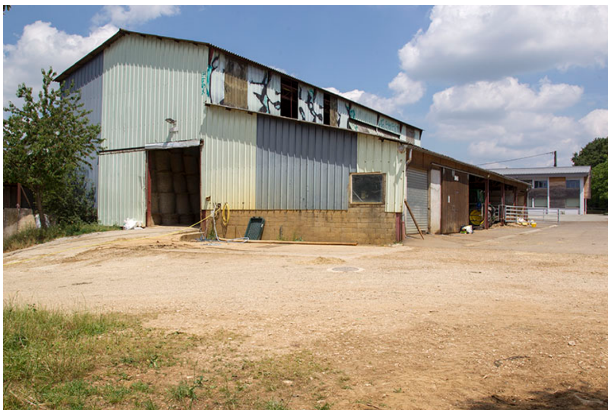
Vue de trois-quart sud-est de l'entrepôt agricole.
