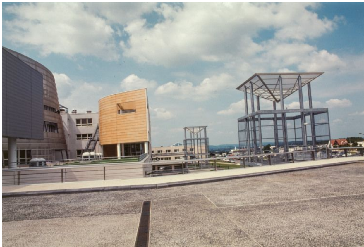
Façade postérieure, vue de la terrasse.
