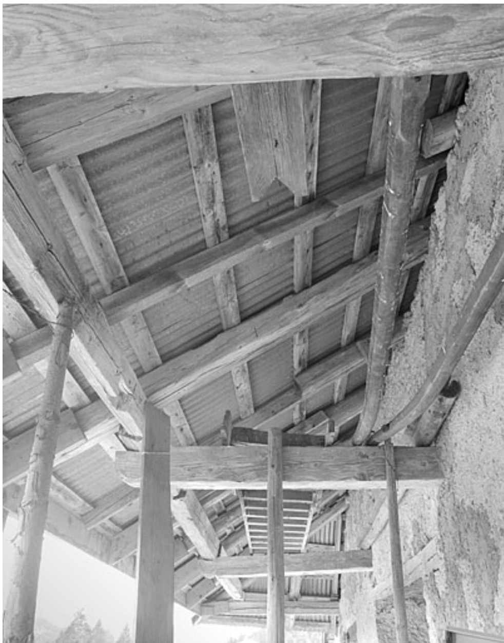
Détail de la charpente de l'avant-toit.
