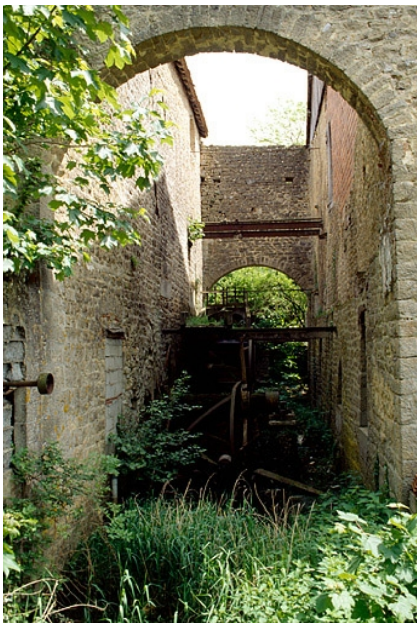
Bâtiment d'eau. Roues hydrauliques en ruine.
