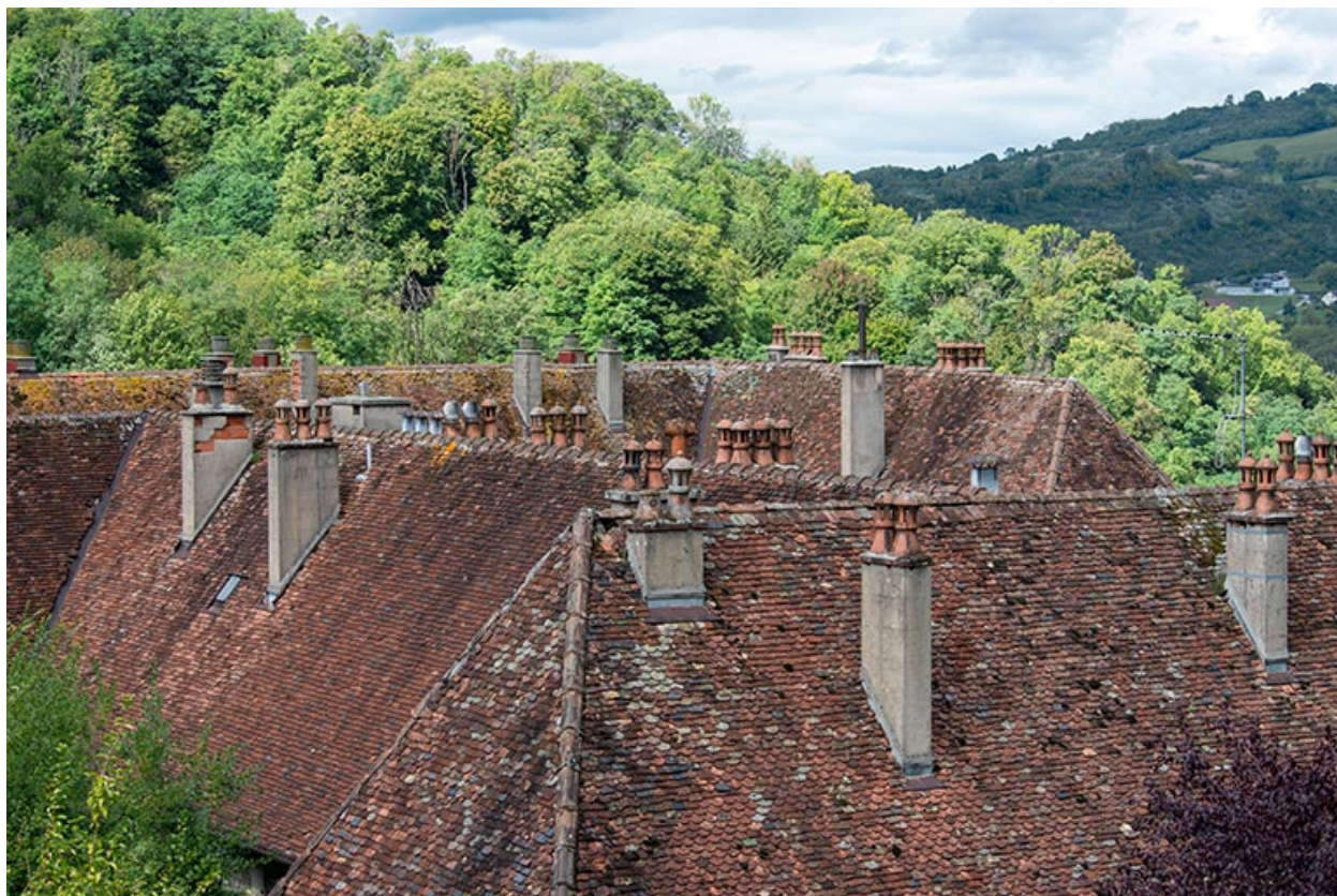
Vue rapprochée sur les toits.
