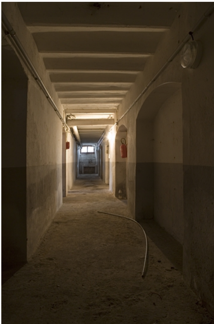
Bâtiment A : sous-sol. Vue du couloir.
