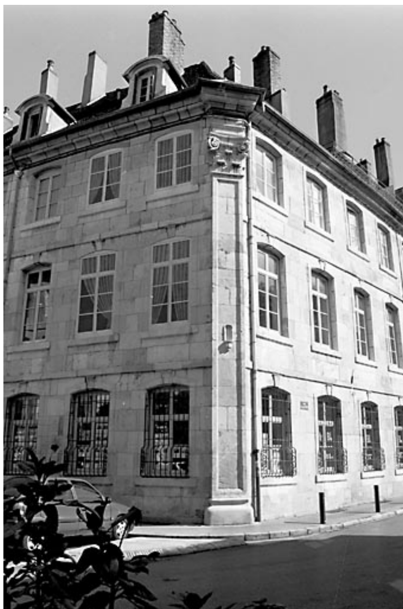
Vue d'ensemble éloignée.
