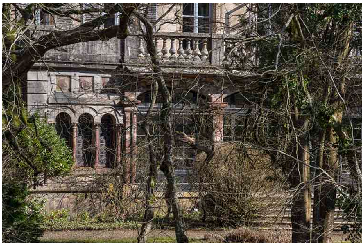
Vue du rez-de-chaussée, façade sud-ouest.
