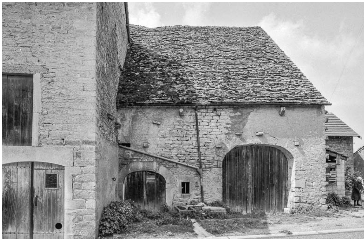
Ferme cadastrée 1951 E1 79 (droite) : façade sur rue.
