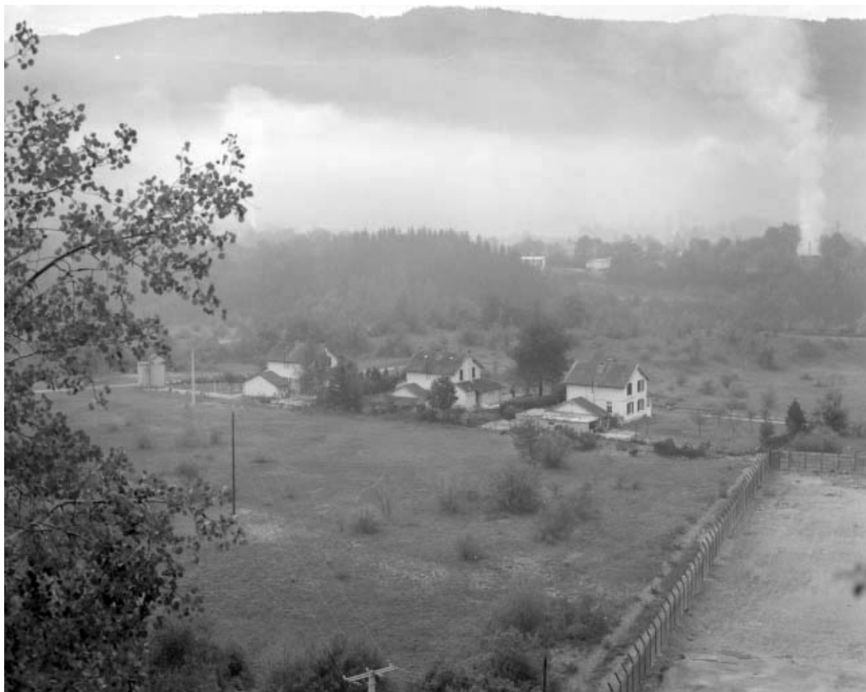
Vue d'ensemble des trois maisons.
