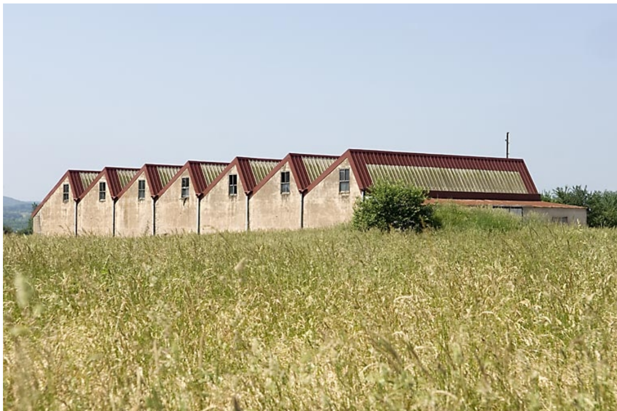
Atelier de fabrication (retorderie). Vue depuis l'est.
