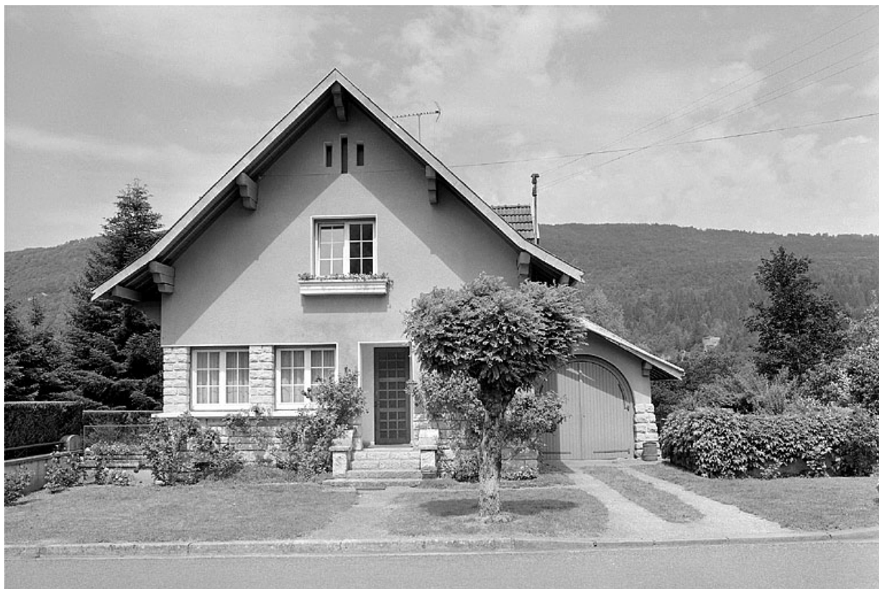
Maison reconstruite après guerre.
