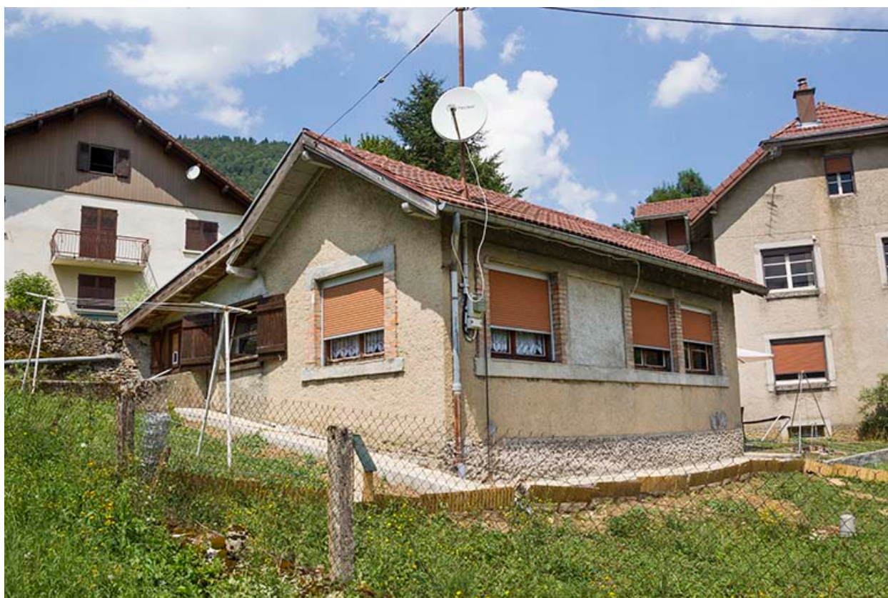
L'atelier de fabrication, depuis le sud.
