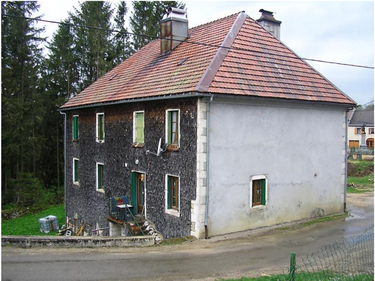
Façade postérieure sud vue de trois quarts.
