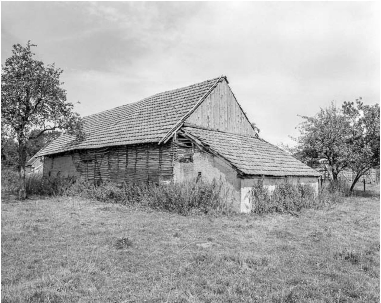
Ferme cadastrée 1963 AB 20 : façade postérieure.
